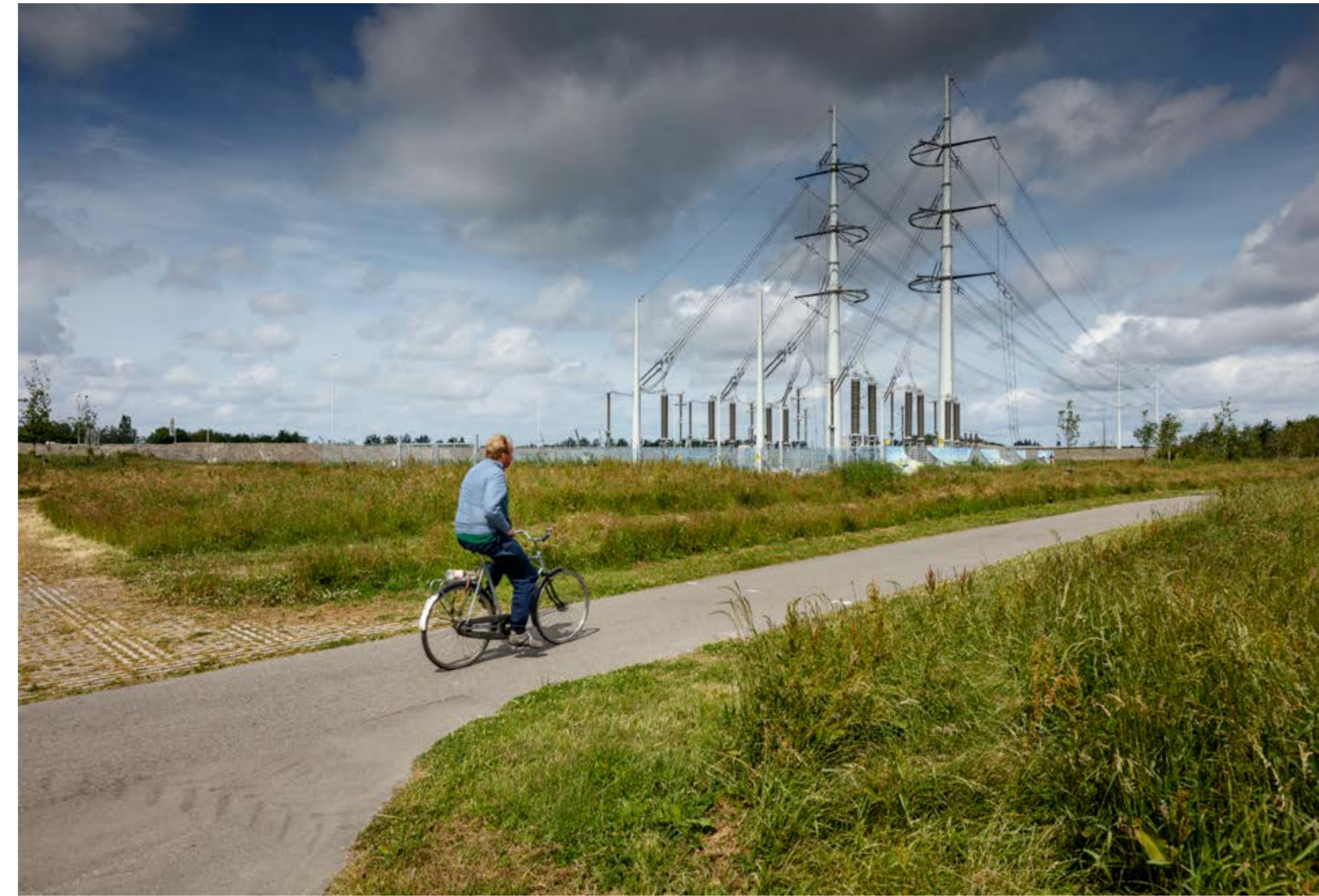
Een 380 kV opstijppunt tbv een ondergrondse verbinding
