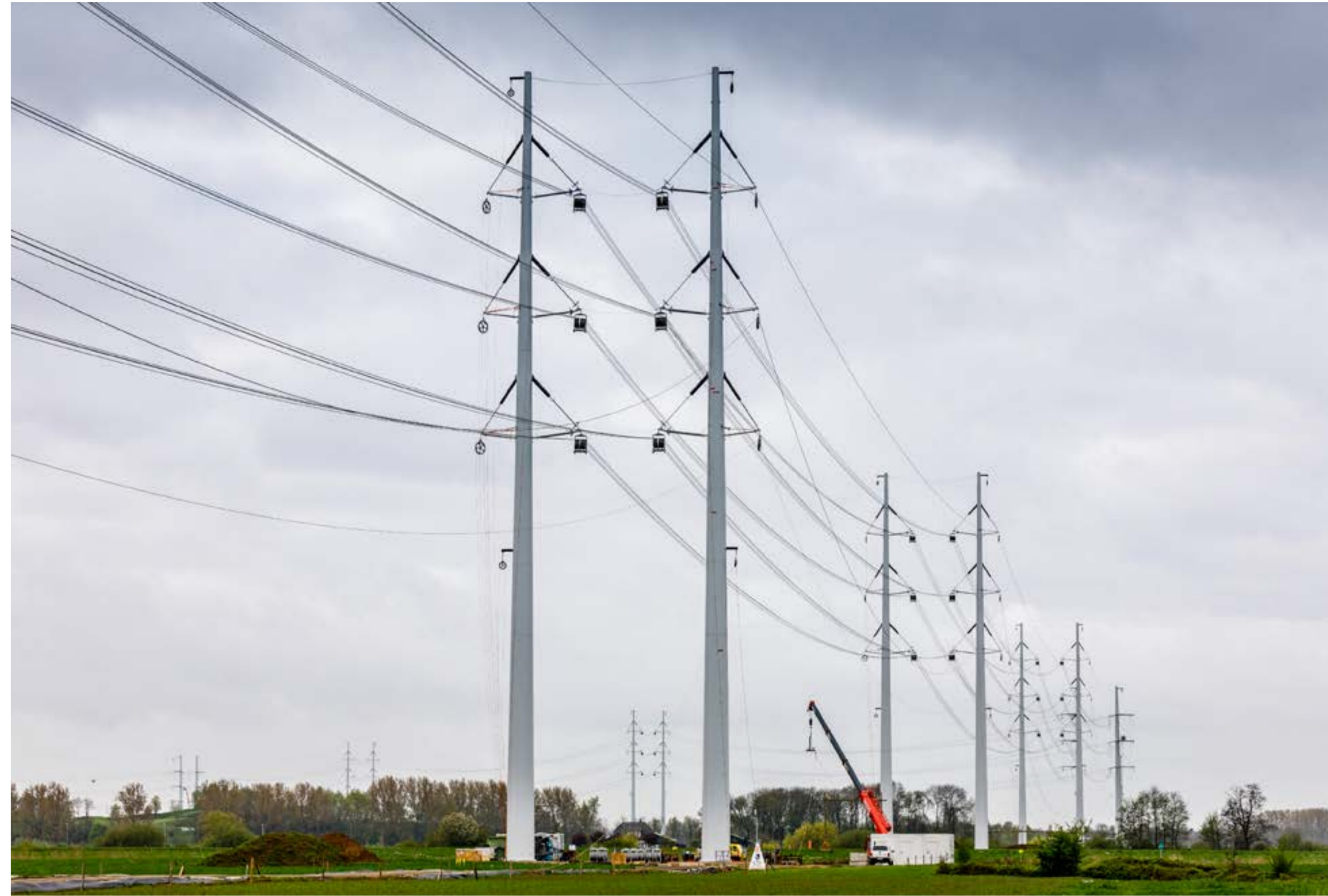
Een Combi 380 kV / 150 kV verbinding in aanbouw
