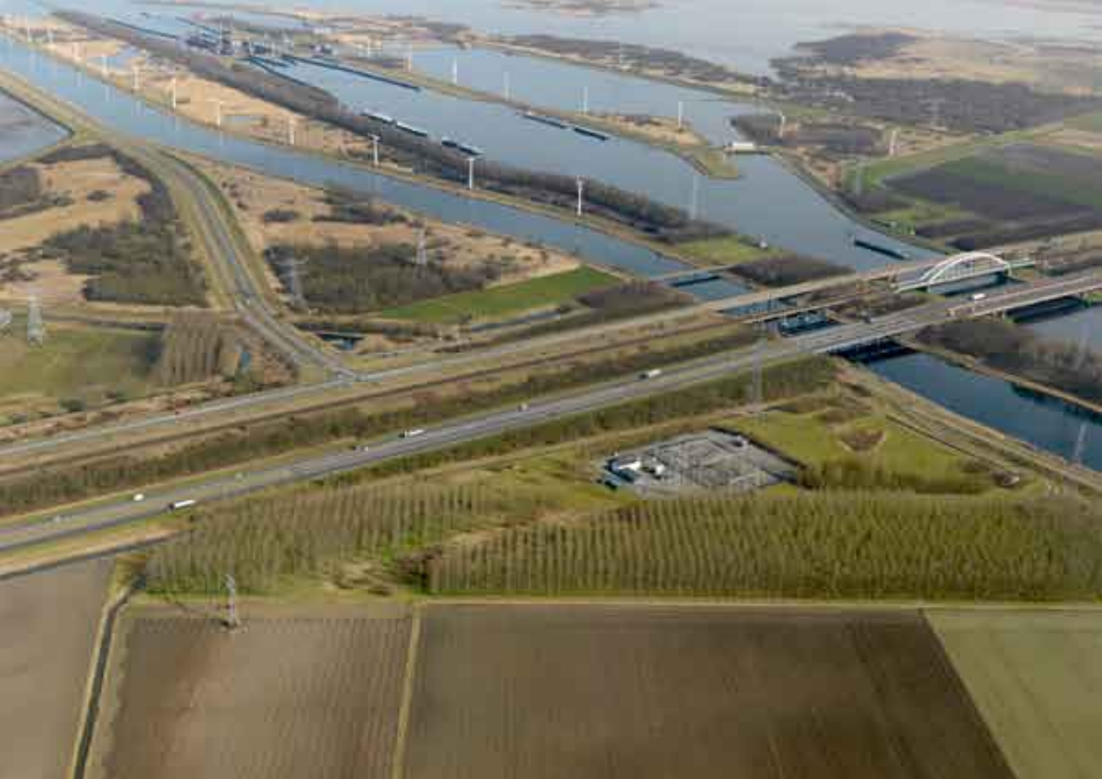
Splitsing van de 380 kV hoogspanningsverbinding richting België en koppelstation 150 kV bij Krekeraksluis.
