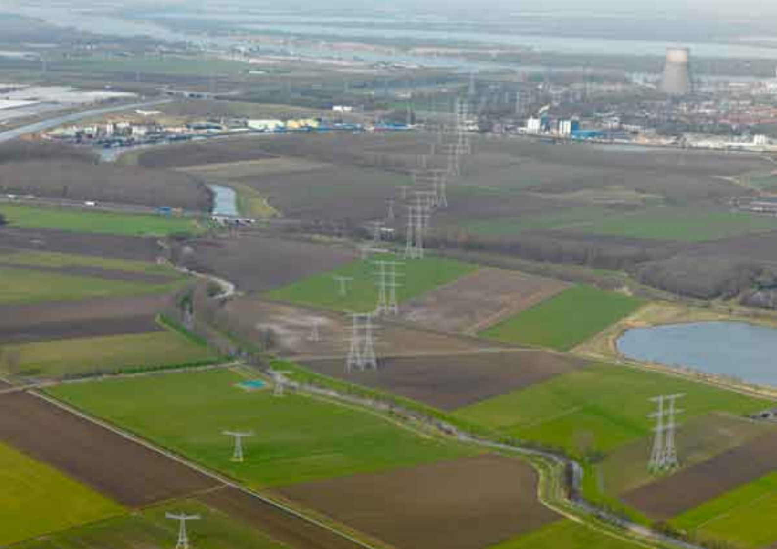
Hoogspanningsverbinding ten zuiden van Geertruidenberg (bundeling 150 kV en landelijke ring 380 kV en Amer centrale).
